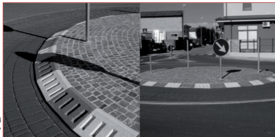
Ipotesi di cordoli utilizzabili per la delimitazione dell'installazione.
